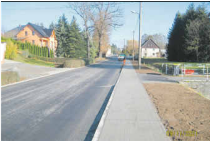
Neuer Gehweg an der Dorfstraße
