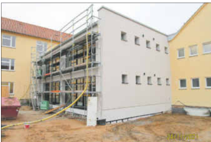
Aktueller Baustand zum Anbau Basaltus-Grundschule
