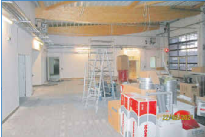
Innenausbau Fahrzeughalle (Feuerwehrgerätehaus)
