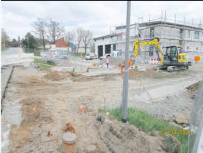
Beginn Freianlagenbau Feuerwehrgerätehausneubau
