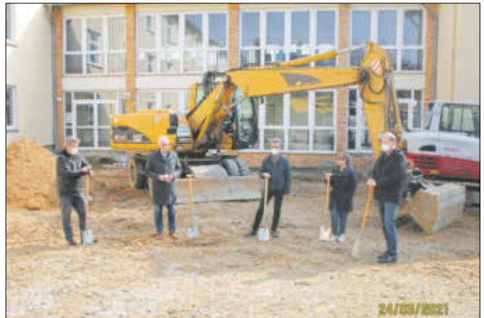
Bauginn mit 1. Spatenstich Grundschulanbau Stolpen
