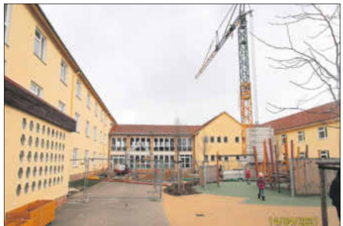
Baustelle Anbau Basaltus-Grundschule Stolpen
