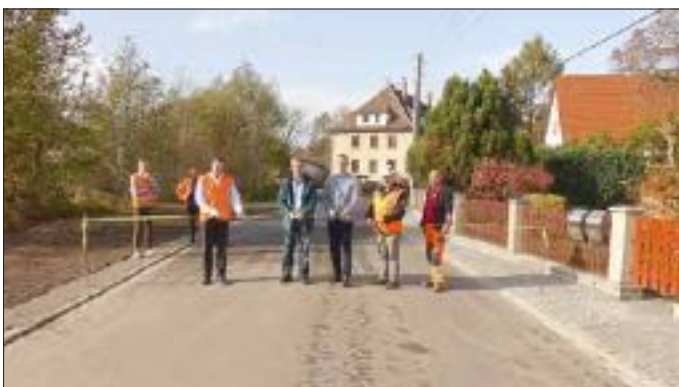
Übergabe des sanierten Straßenabschnittes vom Mittelweg
