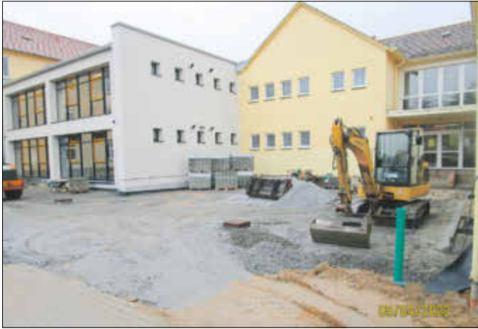
Tiefbauarbeiten im Baustellenbereich am Anbau der Basaltus-Grundschule Stolpen
