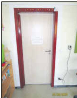
Neue Klassenraumtür in der Basaltus-Grundschule Stolpen
