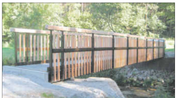
Ansicht sanierte Brücke über die Polenz
