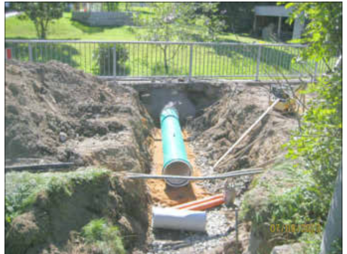
Einbau neuer Gewässerdurchlass in der Hauptstraße
