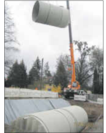
Einbau der beiden Behältertei- le mit Mobilkran
